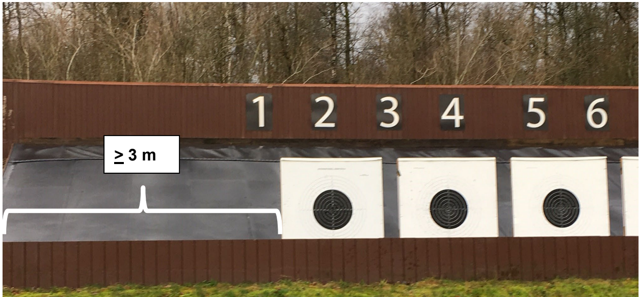
Bild 2:4. Kulfångsbredd vid skjutning mot mål/ målställning
