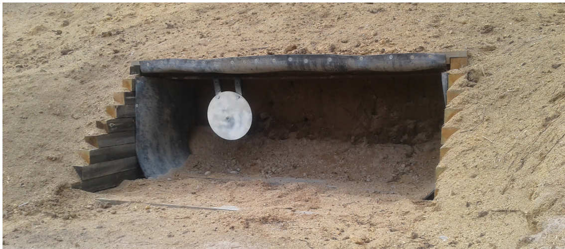
Bild 3:5. Kulfång med ingrävt splitterskydd för metallmål
